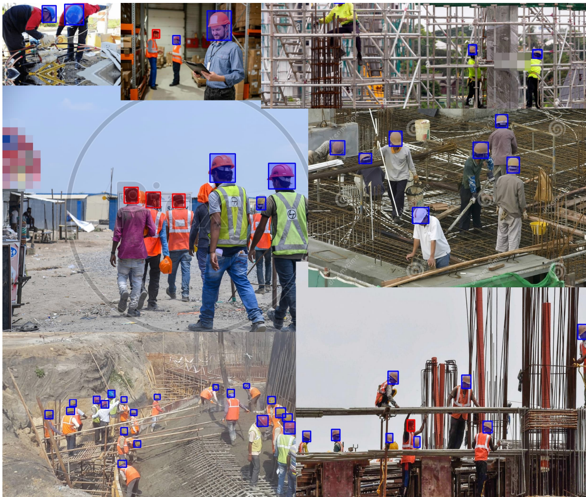
شکل ۷-۱: نمونه‌ای از کارایی سامانه آماندا در تشخیص به سر داشتن یا نداشتن کلاه ایمنی
